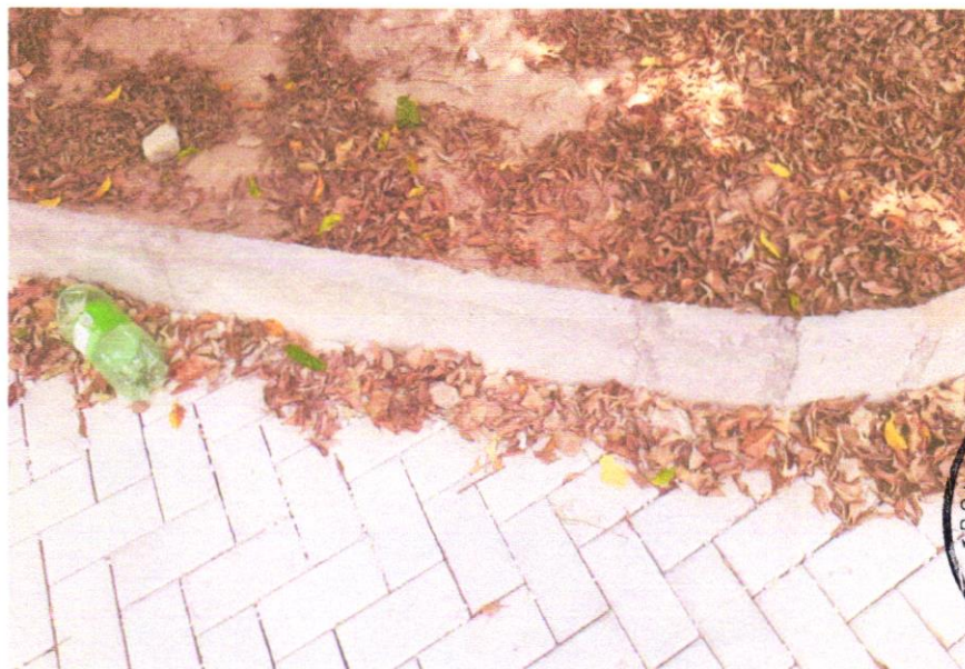
FOTO 04 - ASSENTAMENTO DE GUIA (MEIO-FIO) EM TRECHO RETO, CONFECCIONADA EM CONCRETO PRÉFABRICADO, DIMENSÕES 100X15X13X20 CM (COMPRIMENTO X BASE INFERIOR X BASE SUPERIOR X ALTURA), PARA URBANIZAÇÃO INTERNA DE EMPREENDIMENTOS.
