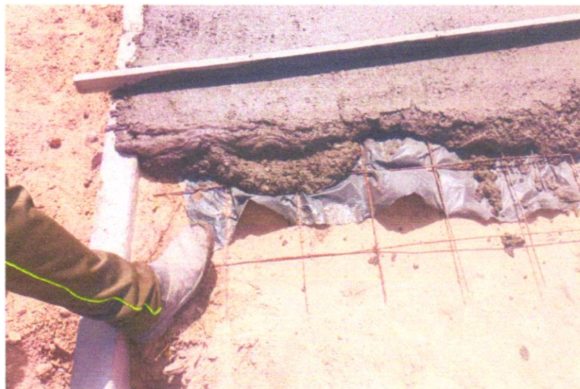
FOTO 06 – PAVIMENTAÇÃO EM CONCRETO, COM ESPESSURA DE 7 CM, COM ACABAMENTO FEITO UTILIZANDO ALISADORA DE CONCRETO (HELICÓPTERO), INCLUIDO TELA DE AÇO SOLDADA NERVURADA CA60, Q196 (3,11 KG/M 2 ), DIÂMETRO DO FIO 5.0 MM, LARGURA = 2,45 M, ESPAÇAMENTO DA MALHA = 10 X 10 CM, JUNTA DE DILATAÇÃO EM PVC A CADA 2,00 M, CONCRETO FCK = 20 MPA
